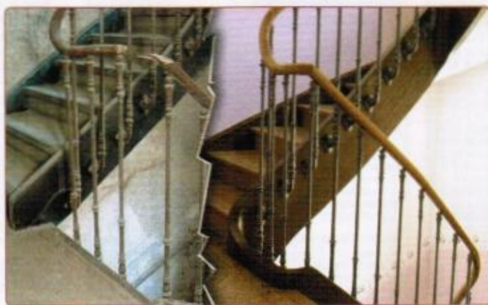
Holztreppe und Geländer halten etwa 100 Jahre, dann steht eine Sanierung an. Die Firma Hammerl verleiht den Treppenhäusern wieder ihren alten Glanz.
